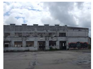
The Campanhã station area
