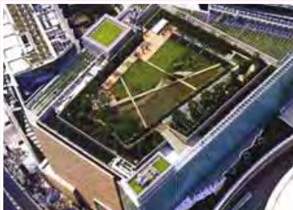
Telhado verde em Roppongi Hills
