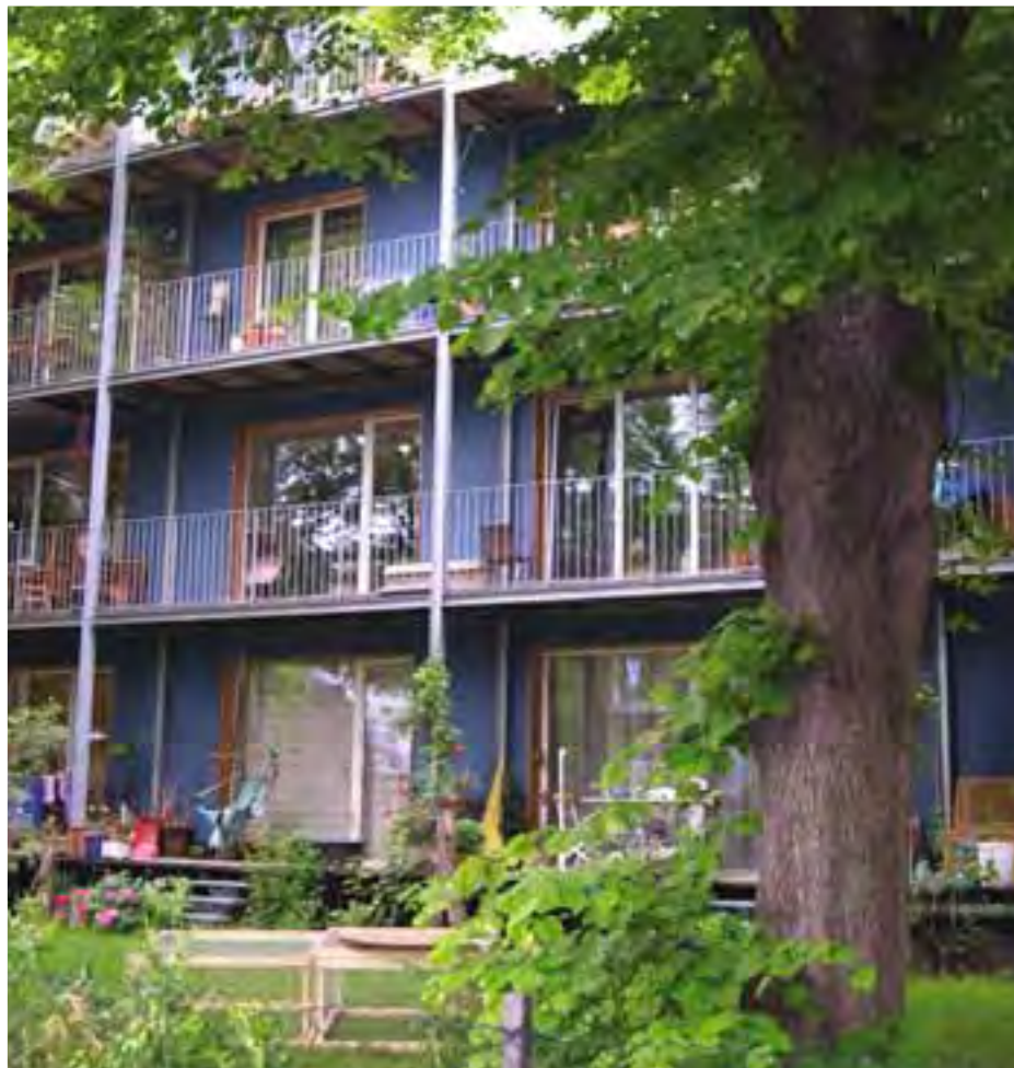
Varandas da fachada sul das casas passivas no bairro de Vauban
